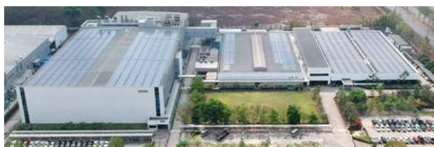
L'impianto di generazione di energia solare sul tetto dello stabilimento Epson in Thailandia.
